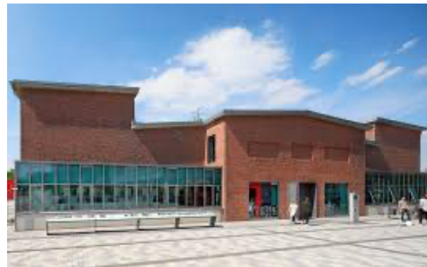
Die frühere Großviehhalle.
